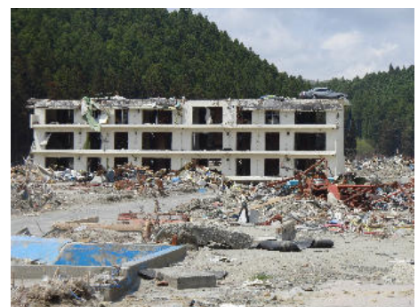
屋上に乗用車が乗った建物
