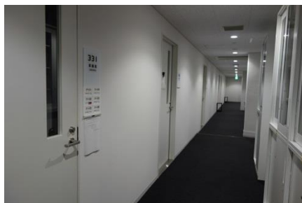
写真D 新実験室 (写真Cと同じ位置から撮る: 左手前が331実験室で室内 は小さなブースが6つある)
